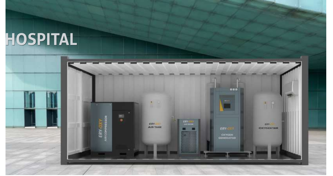
Hastane dışına yerleştirilen Örnek Medikal Oksijen Üretim Sistemi
